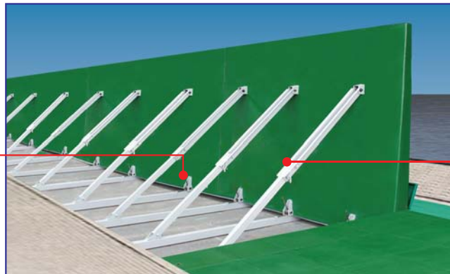
Fix brace with pin ใส่สลักยึดค้ำยัน
